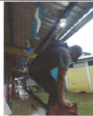
Foto 10: Sustitución de focos ahorradores
