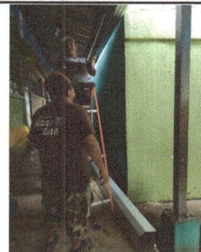
Foto 6: Sustitución de canal de metal
