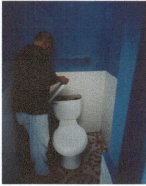
Foto 7: Sustitución de inodoros
