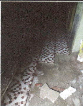
Foto 5: Sustitución de piso cerámico
