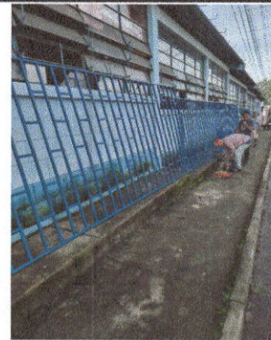
Foto 4: Sustitución de balcones de metal
