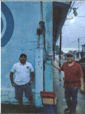
Foto 9: Reparación sistema eléctrico
